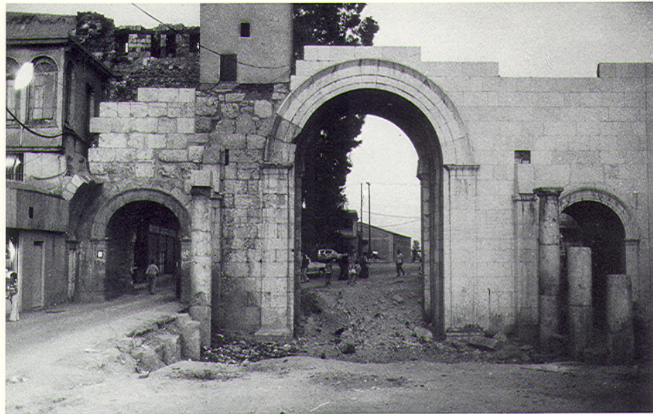
a Antikes Osttor, Bāb Šarqī (Nr. 1.8), Innenseite während der Restaurierung 1975
